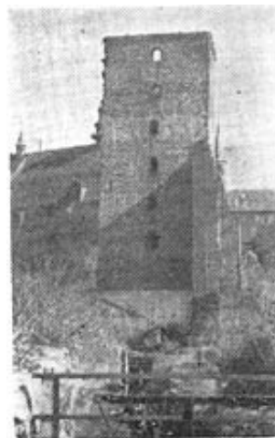
Wieża XVI-wiecznego wodociągu, strona północno-zachodnia. U dołu widać sklepienie nad przepustem kanału
